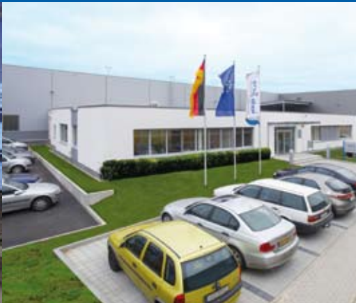
Karle + Jung, plant in Ötigheim
