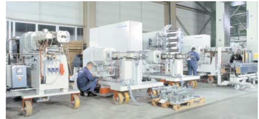
Blick in die Extruderanlage
